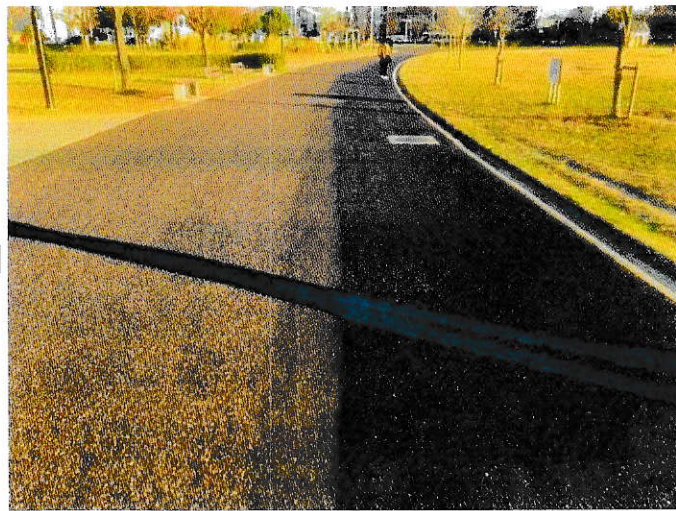
洗出し施工後
